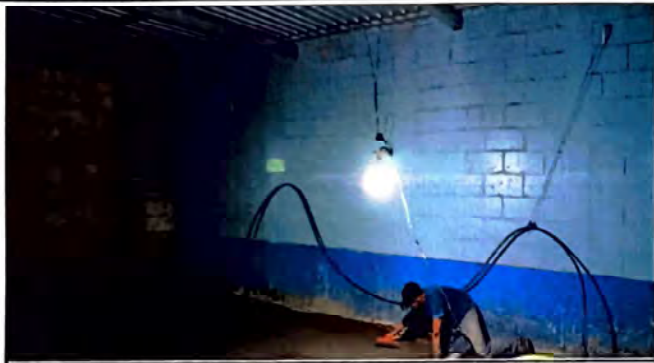
Foto1: se trabajó el piso de aulas con la ayuda de padres de familia, incluso se tuvo que trabajar en horas de la noche.
