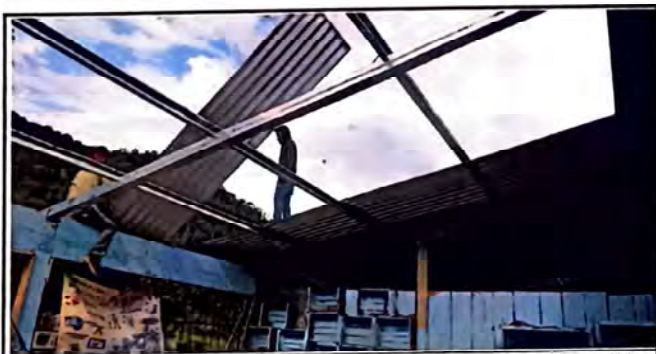
Foto 21: se modificó el entechado e un módulo de dos aulas con medidas de 17 metros por 8 metros.
