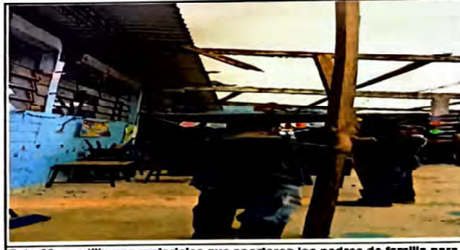
Foto 22: se utilizaron materiales que aportaron los padres de familia para solventar los trabajos.
