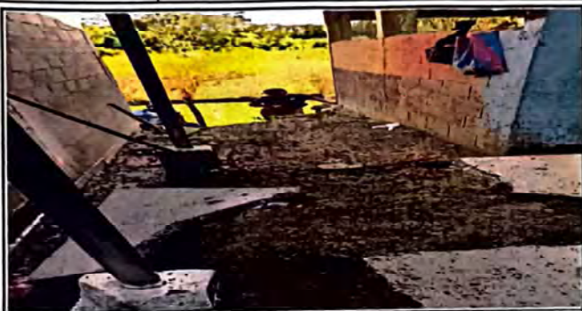
Foto 19: la restauración del piso de aulas lleva trabajo y dedicación porque realmente ya estaba en deficiente presentación.
