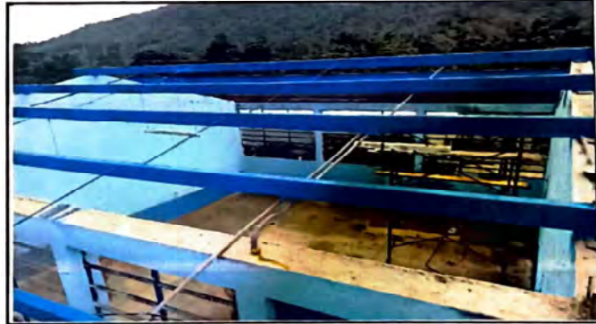
Foto 4: las aulas tomaron nueva vida ya que el techo que tenían ya estaba muy gastado, se pudo instalar costaneras y tuvos cuadrangulares de alta calidad.
