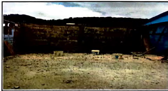
Foto 6: el cambio de piso de aulas era ya necesario que por años estuvo en condiciones precarias.
