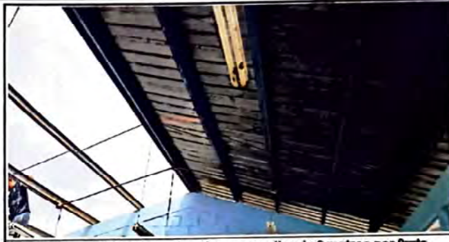
Foto 20: Se cambió el techo de aulas con medidas de 9 metros por 9mts. Así como aulas de 8 x 7.50 metros.
