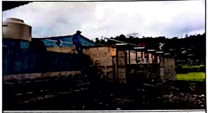
Foto 2: Se instaló techo de buena calidad con costaneras y vigas de la medida solicitada.
